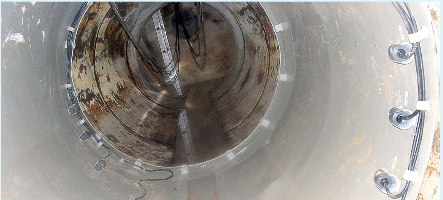
DER MONTAGERING: beim Einfahren in den engen Abwasser-Kontrollschacht.
