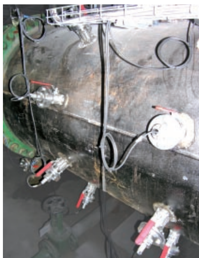
Anordnung der Messstellen an Kühlwasserzulaufleitung
