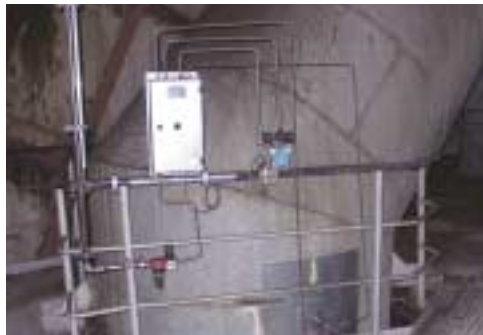
DF25 mit LSP für stark staubhaltige Verbrennungsluft nach LuVo
