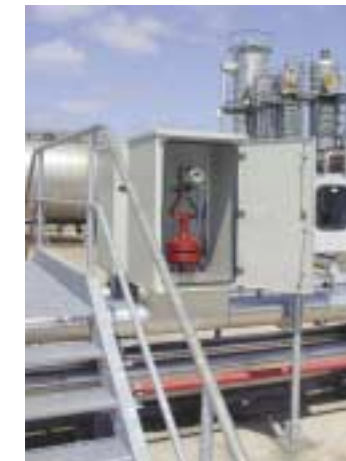
DF25HD für verschmutztes Hochdruckerdgas hinter Bohrkopf
