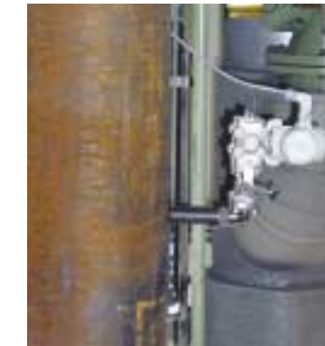
Deltaflow für feuchte Luft zum Belebte Becken
