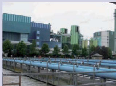
Flüssigkeits-/Gas-Durchflussmessungen in der Abwasseraufbereitung sind typische Messaufgaben
