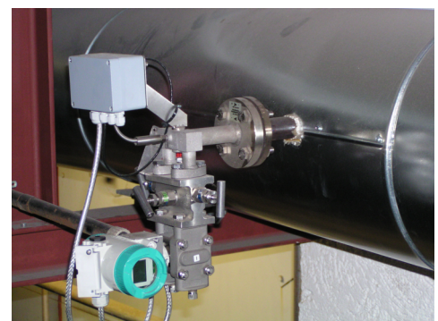
Abbildung 3: deltaflow für Dampfleitung mit direkt montiertem dp-Transmitter (auf Dreiegeblock), integrierter Temperaturmessung und Anschlusskasten (für Verkabelung)
