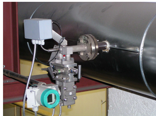
Abbildung 3: deltaflow für Dampfleitung mit direkt montiertem dp-Transmitter (auf Dreibegeblock), integrierter Temperaturmessung und Anschlusskasten (für Verkabelung)
