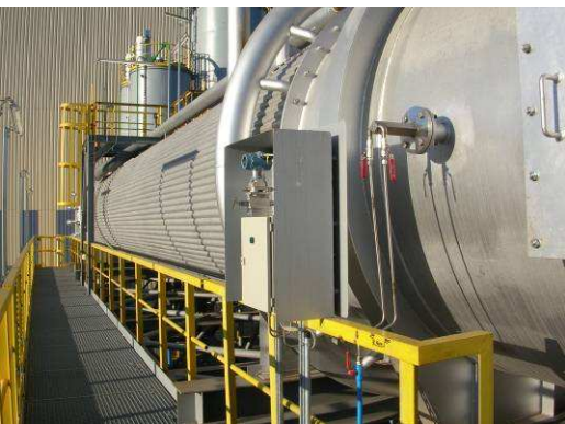
Abbildung 2: deltaflow mit Luftspüleinrichtung LSP (Verbindung durch Impulsleitungen)
