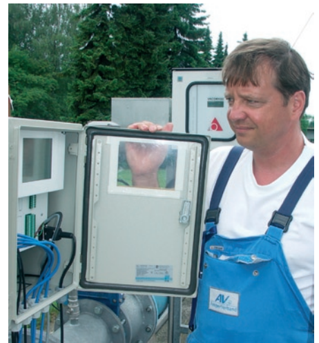
Abwassermeister Adam Feigel betreibt die Testmessungen
