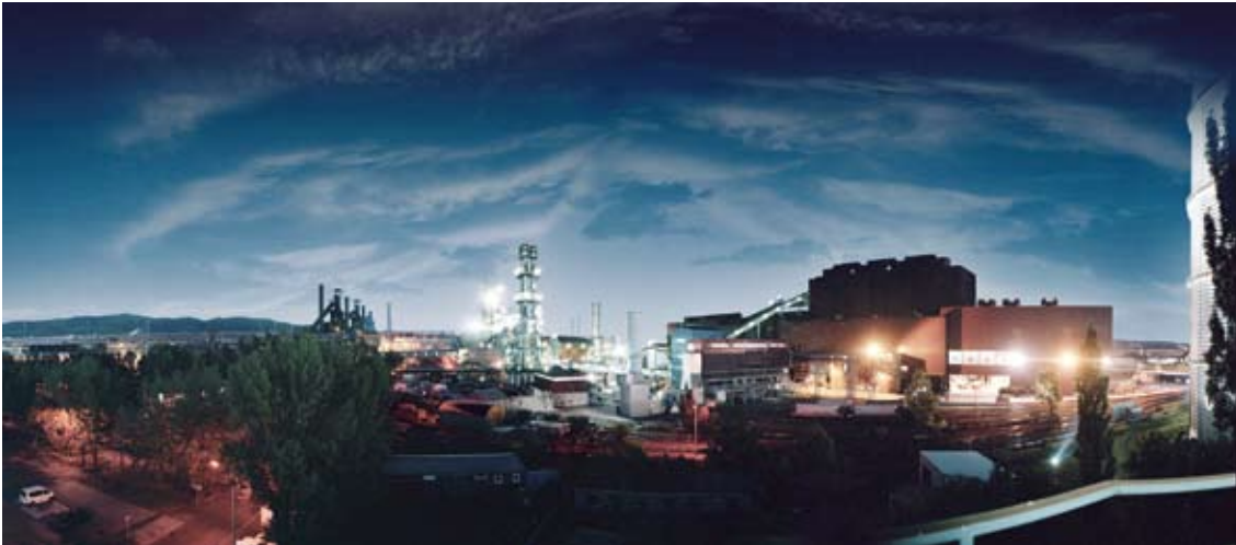
In einem integrierten Hüttenwerk wie in dem der voestalpine Stahl GmbH in Linz hat die Optimierung der Kühlwasserversorgung eine große Bedeutung
