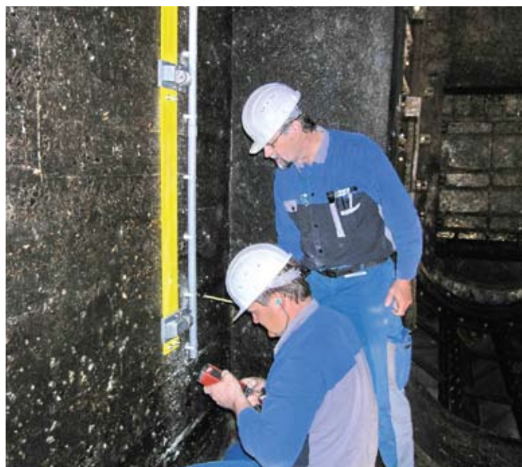
Montage und Justage der deltawave-Ultraschallwandler
