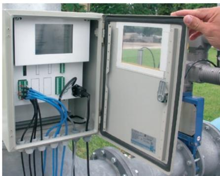
Deltawave mit geöffnetem Gehäuse
