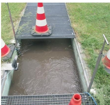
An dieser Stelle im offenen Gerinne sind die Ultraschallsensoren an den Seitenwänden des Gerinnes diagonal gegenüber liegend installiert.
